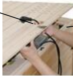
Abb. 29 Führen Sie den Netzstecker durch die äußere obere Abdeckung und befestigen Sie ihn mit 8 4 x 25 mm Schrauben.
